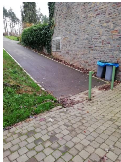
A l'arrière du bâtiment
